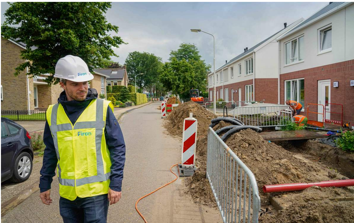
In 2024 werkten we via dochteronderneming Firan in verschillende gemeenten aan de aanleg en uitbreiding van warmtenetten.
